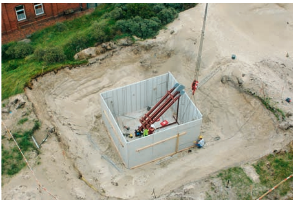
Abb. 10: Abspannfundament Nr. 2
